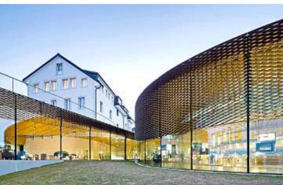
Una malla de latón reviste la superficie exterior para regular la temperatura.
